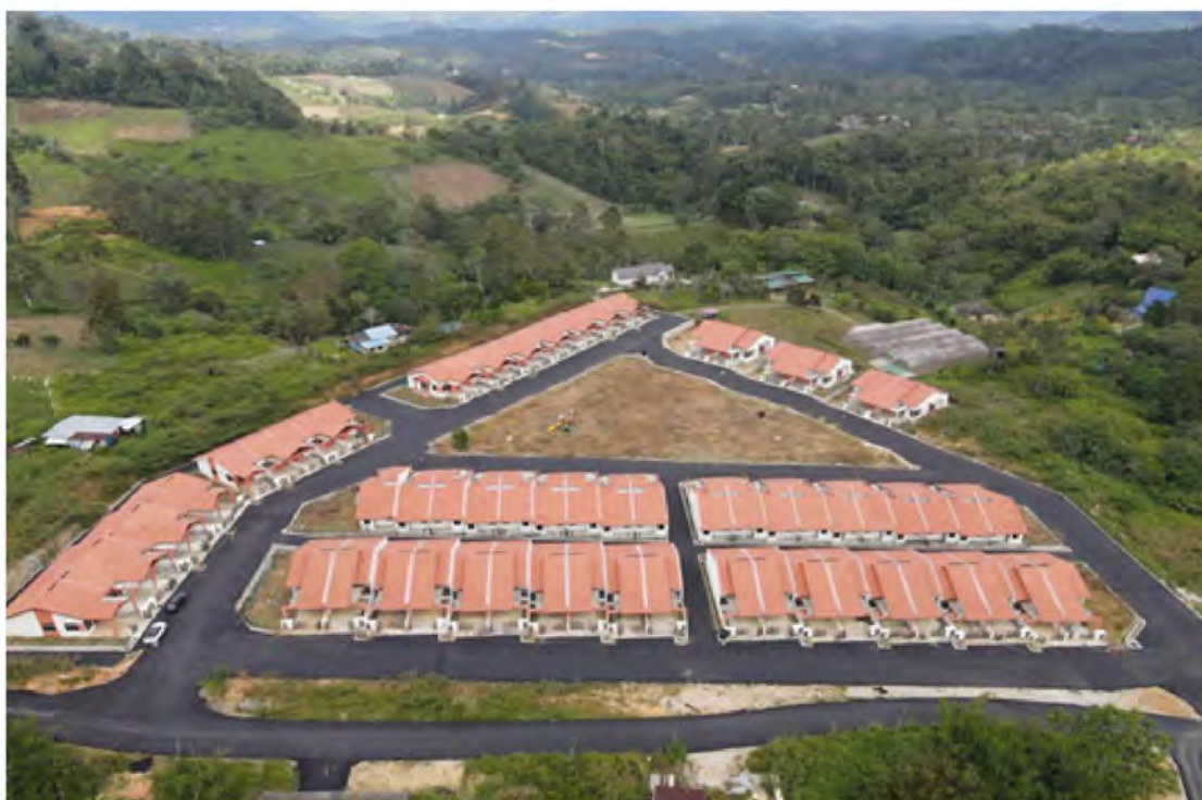
Projek Perumahan Chemperoh, Bentong
